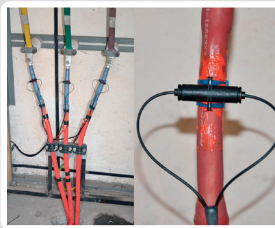
Fot. 2. Przykład montażu czujników optycznych
